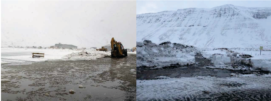
Mynd 21. Svæðið var drenað með gröfu og við það minnkaði vatnið. Tunnan var látin standa aðeins meira upp úr jörð en áður til að minnka líkurnar á að vatn komist inn í hana.
